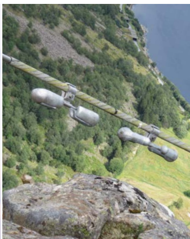
◀ Schwingungsdämpfer Montage auf Schutzspiralen.
